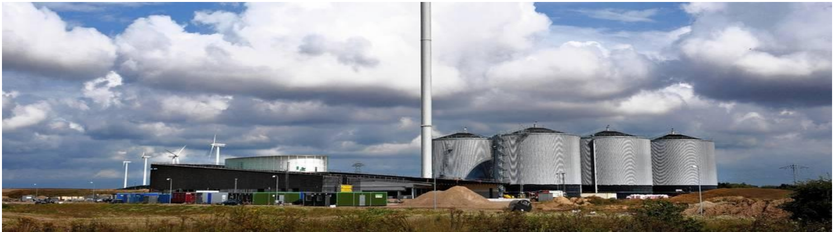
Maabjerg Energy Concept, biogas plant, Måbjerg, Denmark
